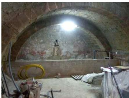
**Fig. 18.** Estado actual del aljibe del castillo con un forjado de hormigón sobre el antiguo vaso. J.A. Benavente, 2007.
